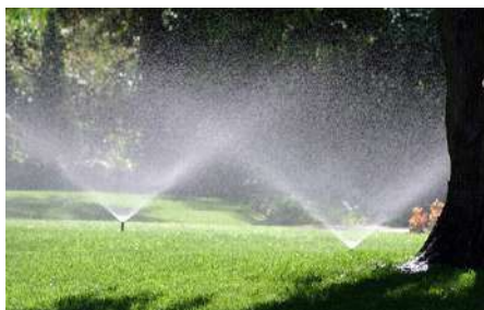
Fig 5: Spërkatës që dalin nga toka nën presion të ujit
